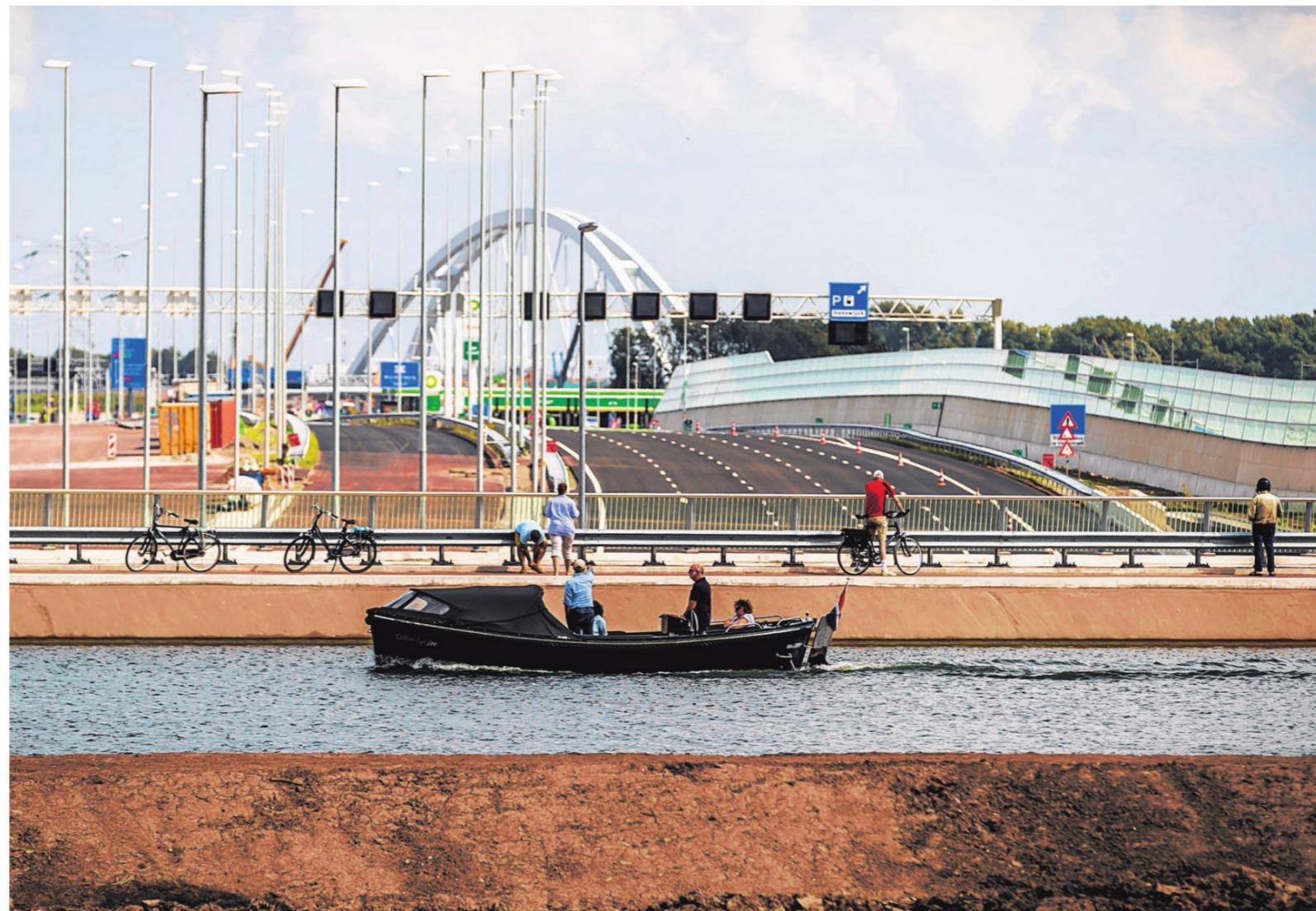
▲ Het nieuwe aquaduct waar de A1 bij Muiden onderdoor schiet. FOTO REMKO DE WAAL/ANP
